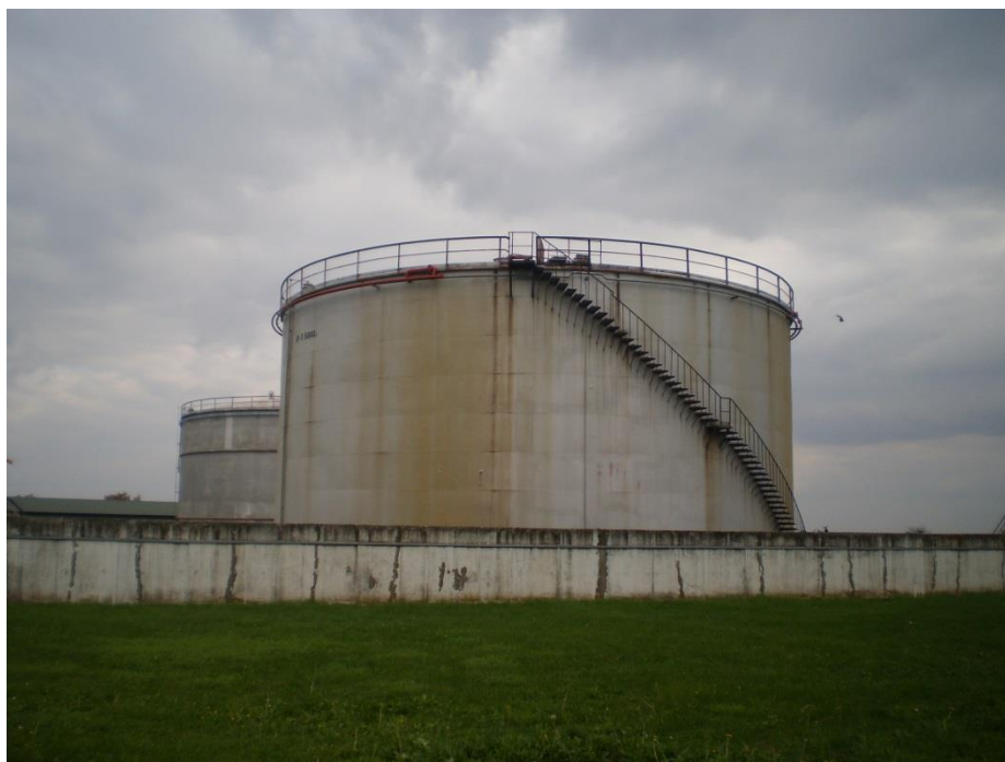
Slika 25. Spremnici nafte (5000 m 3 )
